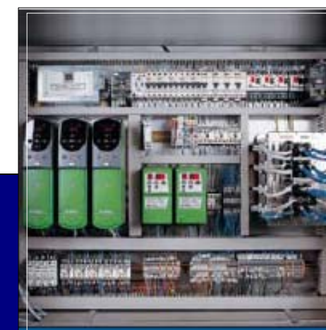
Cuadro eléctrico con control por PC Industrial
