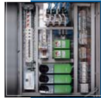
Cuadro eléctrico Electrical panel Panneau électrique
